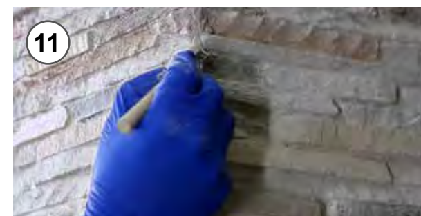
11 - A parziale essiccazione avvenuta, rifinitura e modellatura stucco mediante utensilino e pennello 11 - Once partly dry, finish and modelling the grout using a small utensil and brush
