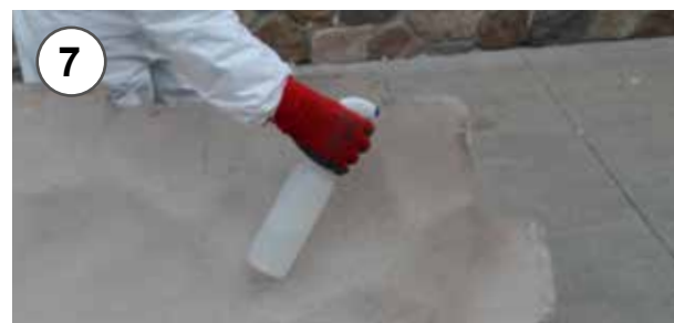
7 - Acqua nebulizzata sul retro del pannello per migliorare la presa 7 - Water spray on the back of the panel, to improve grip
