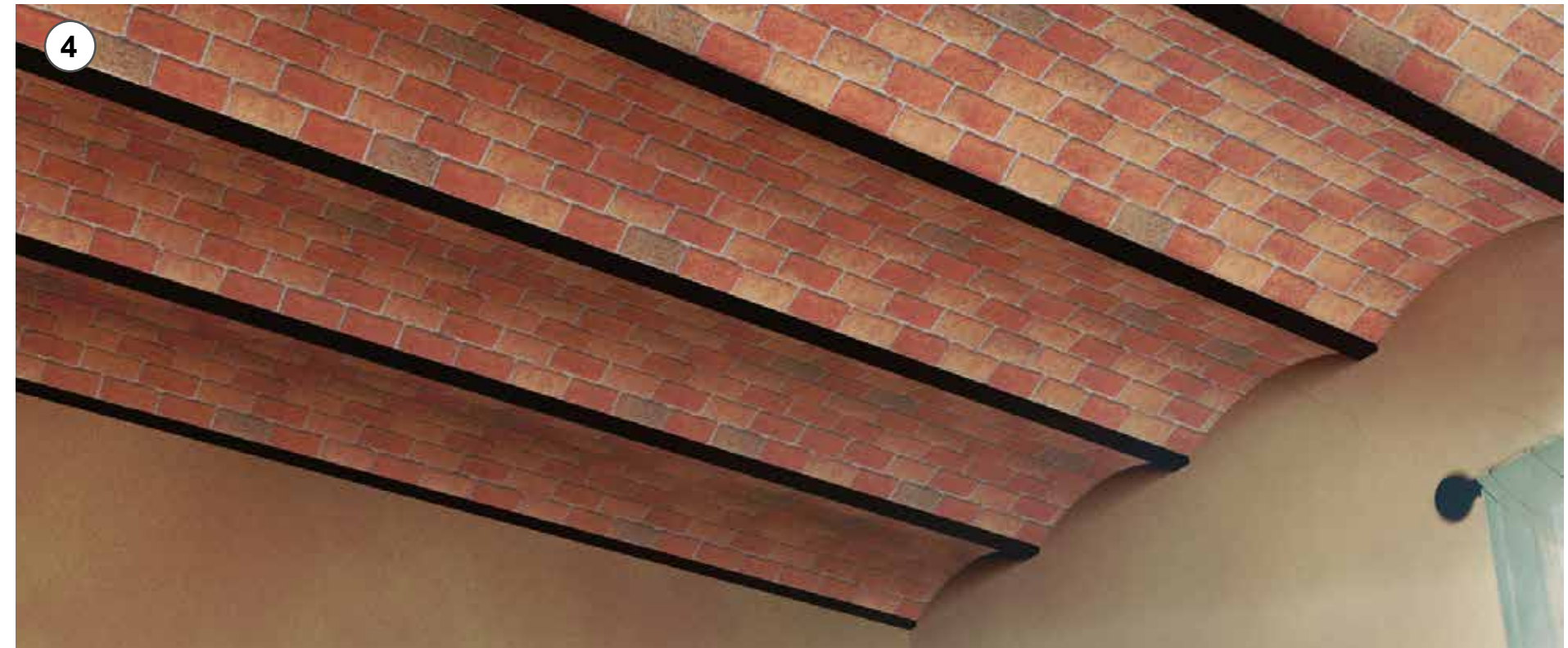
4 - Controsoffitto ultimato. 4 - Completed suspended-ceiling.
