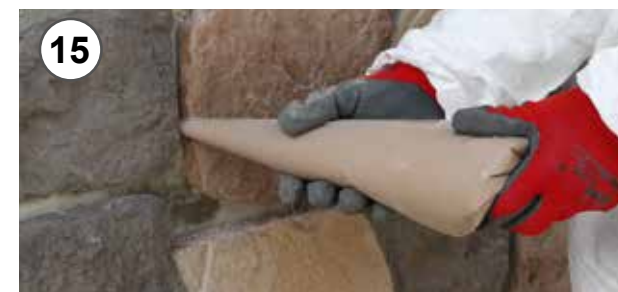
15 - Applicazione dello stucco mediante sac a poche 15 - Grout application using pastry bag
