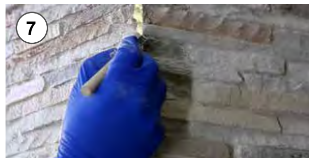
7 - Pulizia del giunto dai residui di schiuma fuoriuscita 7 - Joint cleaning from foam residues
