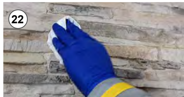
22 - Tamponare con carta assorbente l'eventuale ossido in eccesso 22 - Dab with absorbent paper the eventual oxide in excess
