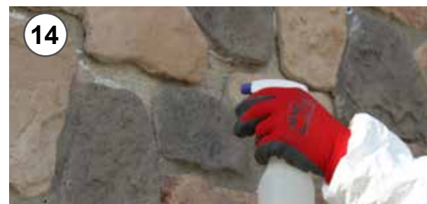
14 - Umidificazione del giunto con acqua nebulizzata prima dell'applicazione dello stucco 14 - Humidification of joint by water spray before grouting.
