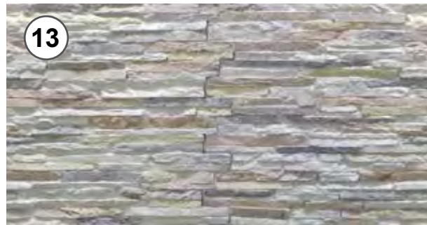
13 - Giunto pronto per l'applicazione degli ossidi coloranti da effettuarsi a totale essiccazione dello stucco 13 - Joint ready for the application of colored oxides after total drying of the grout
