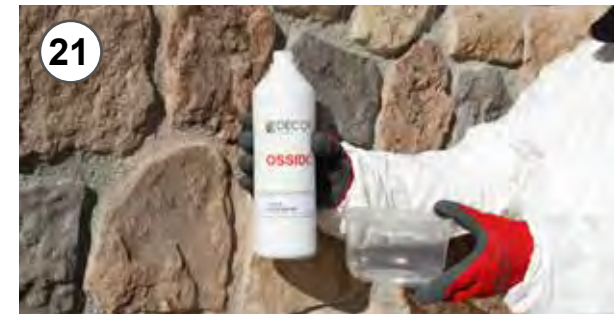
21 - Versare parte di ossido miscelato in un contenitore 21 - Pour the mixed oxide into a little container
