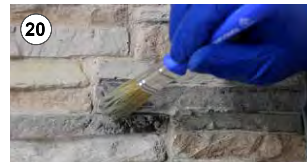
20 - Ossidatura giunto colore grigio 20 - Joint oxidizing by gray colour
