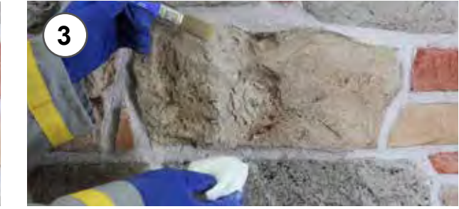
3 - Modellatura dello stucco con pennello e carta assorbente 3 - Application of the glue on the wall
