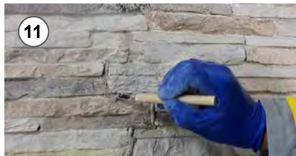
11 - A parziale essiccazione avvenuta, rifinitura stucco mediante utensilino 11 - Once partly dry, finish the grout using a small utensil
