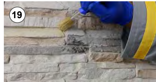
19 - Ossidatura giunto colore giallo 19 - Joint oxidizing by yellow colour
