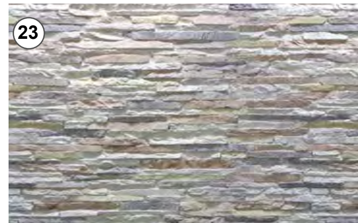
23 - Pannello a lavoro ultimato 23 - The finished panel
