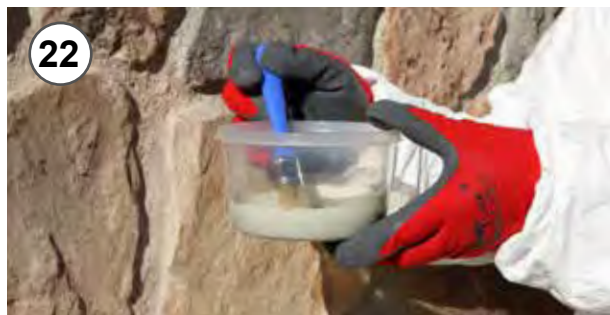
22 - Prima di ogni applicazione, mescolare con pennello per mantenere gli ossidi in sospensione 22 - Before each application, mix by brush to keep oxides in suspension
