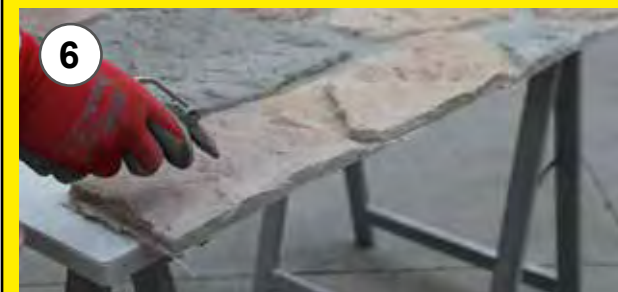
6 - Eliminare polvere e residui 6 - Remove dust and debris
