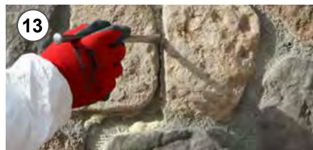
13 - Pulizia dei giunti dai residui di schiuma fuoriuscita 13 - Joints cleaning from foam residues
