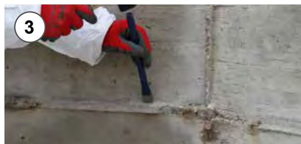
3 - Eliminazione delle imperfezioni 3 - Removal of imperfections
