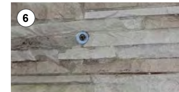
6 - Fissaggio meccanico provvisorio con viti e rondelle da effettuare tra due pietre 6 - Temporary mechanical fastening by screws and washers to be made between two stones
