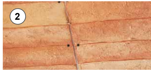
2 - Fissaggio pannello con viti e tasselli collocati in corrispondenza del posizionamento delle travi. 2 - Panel fixing by screws and dowels placed in beams correspondence positioning.
