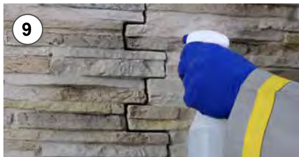
9 - Bagnare il giunto con apposito nebulizzatore prima dell'applicazione dello stucco 9 - Wet the joint with a special nebulizer before grouting
