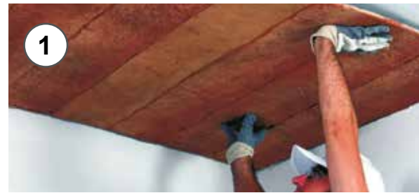
1 - Posizionamento pannello. 1 - Panel positioning.
