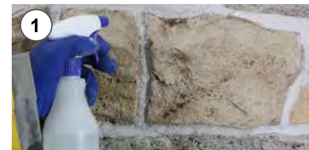
1 - Inumidire con apposito nebulizzatore 1 - Application of the glue on the wall
