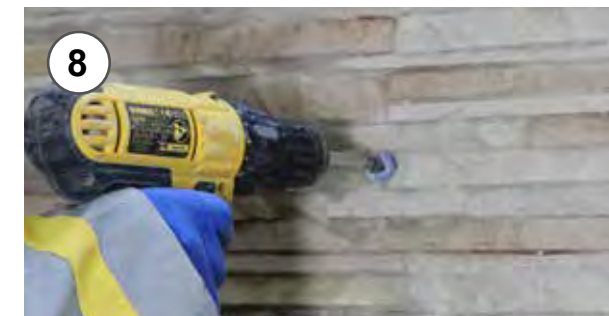
8 - Ad incollaggio avvenuto rimozione di viti e rondelle 8 - On occurred glueing, removing screws and washers
