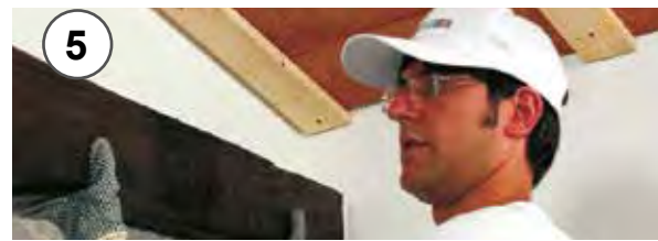
5 - Posizionamento trave 5 - Beam positioning.
