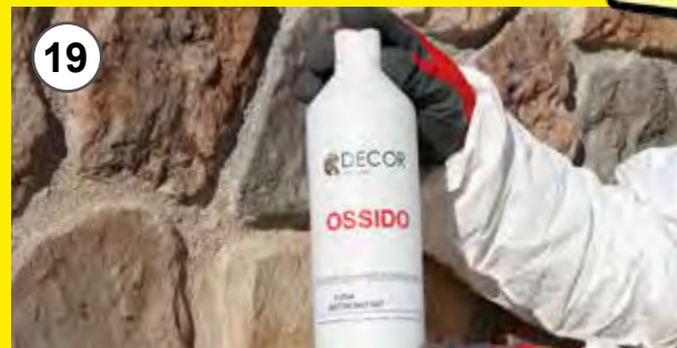
19 - Agitare energicamente l'ossido 19 - Shake vigorously the bottle of oxide
