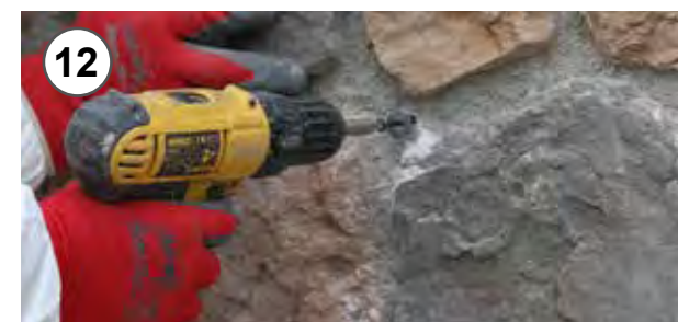
12 - Ad incollaggio avvenuto, rimozione di viti e rondelle precedentemente posizionate 12 - On occurred glueing, removing screws and washers previously positioned
