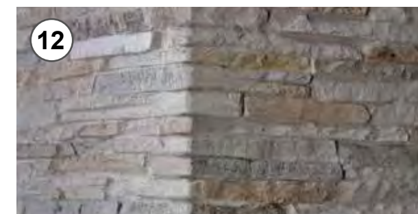
12 - L'angolo pronto per la colorazione con gli ossidi da effettuare a completa asciugatura dello stucco 12 - The corner ready for the colored oxides to be made to complete drying of the glue
