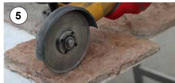
5 - Taglio dei pannelli mediante smerigliatrice 5 - Cutting of panels using the Flex
