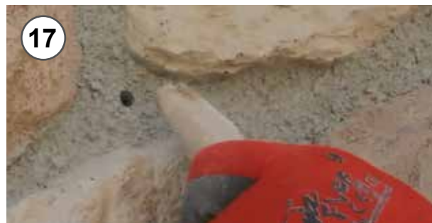
17 - Stuccatura dei fori di fissaggio provvisori 17 - Grouting of temporary mounting holes
