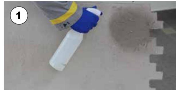
1- Acqua nebulizzata sul retro del pannello per migliorare la presa 1 - Water spray to the back of the panel to improve grip
