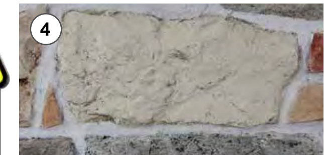
4 - Pennellatura con stucco liquido della pietra ricostruita per uniformarne il colore di fondo 4 - Application of the glue on the wall
