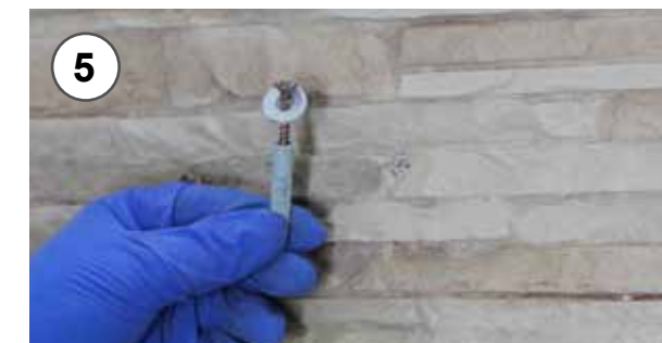
5 - Fissaggio meccanico provvisorio con viti e rondelle 5 - Temporary mechanical fastening by screws and washers
