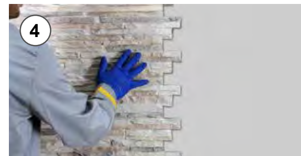
4 - Applicazione del pannello sulla parete con leggera pressione 4 - Applying of panel on the wall with light pressure
