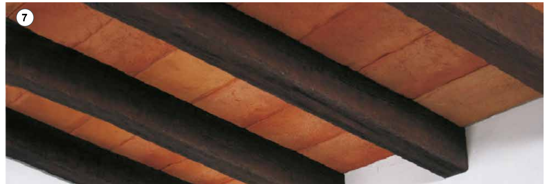
7 - Controsoffitto ultimato. 7 - Completed suspended-ceiling.
