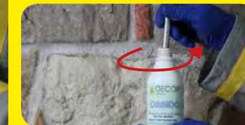
4 - Pennellatura con stucco liquido della pietra ricostruita per uniformarne il colore di fondo 4 - Application of the glue on the wall
