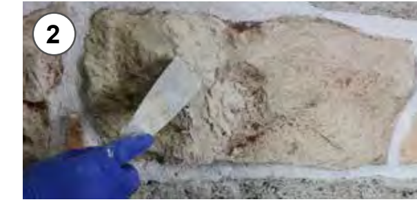
2 - Applicazione dello stucco mediante spatola 2 - Application of the glue on the wall
