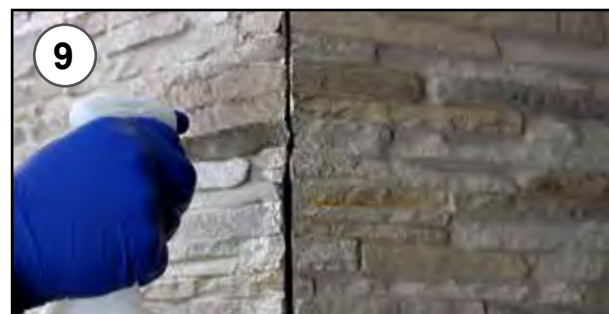
9 - Bagnare il giunto con apposito nebulizzatore prima di riempire con stucco 9 - Wet the joint with a special nebulizer before grout filling
