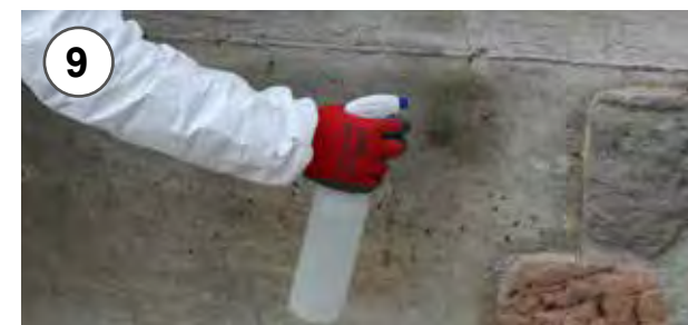
9 - Acqua nebulizzata sul muro per migliorare la presa 9 - Water spray on the wall to improve grip
