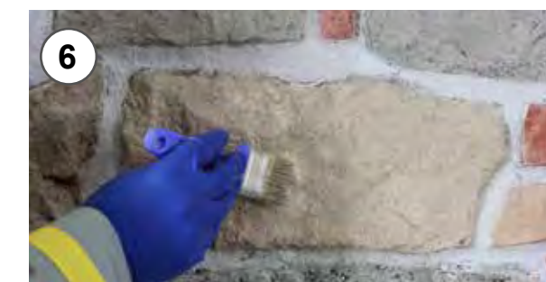
9 - Ossidatura della pietra ricostruita da effettuare a completa asciugatura dello stucco utilizzato per la ricostruzione 9 - Oxidize the stone with a small brush to be made completely at glue dry used for reconstruction
