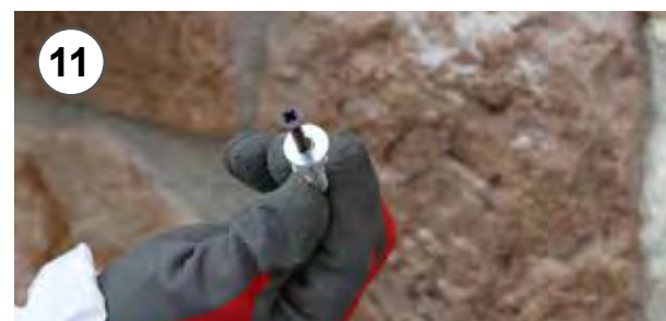
11 - Fissaggio provvisorio del pannello con viti e rondelle sino a presa della schiuma 11 - Temporary fastening of the panel by screws and washers until the foam grip
