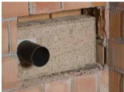
Posizionamento del BIOSILENZIO nella nicchia all'interno del muro perimetrale.
