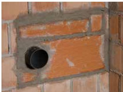
Chiusura del muro interno con tavelle di laterizio.
